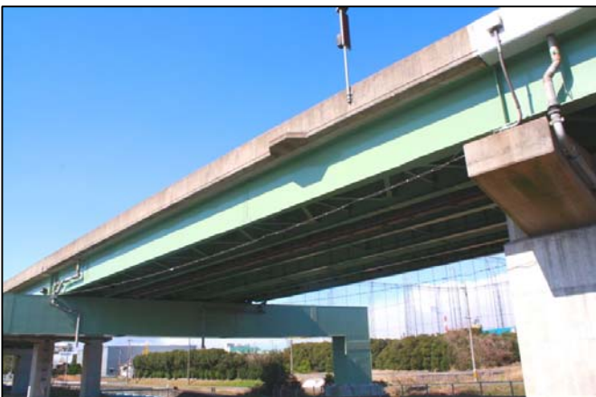
四日市高架橋(近鉄跨線橋)
