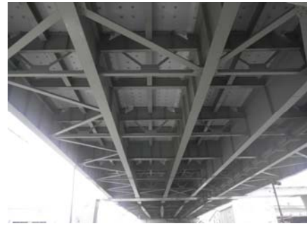
四日市高架橋P12～P14表面被覆工 起点から望む
