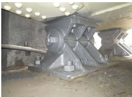
雨池橋 支承補修工
