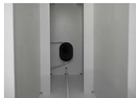
雨池橋 内面塗装工
