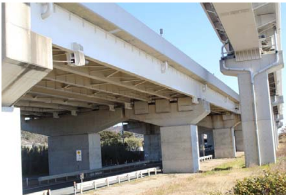
白須賀高架橋
