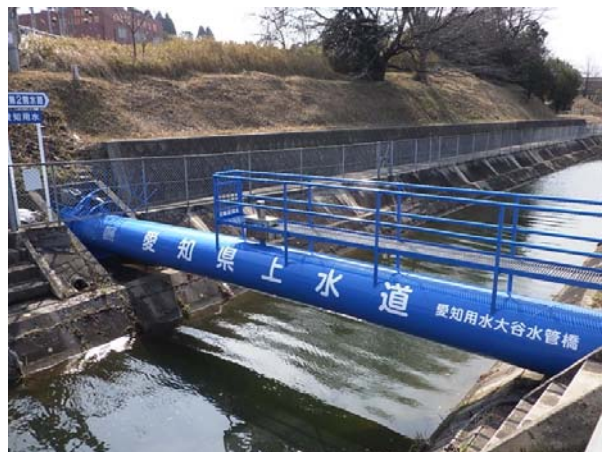
愛知用水大谷水管橋
