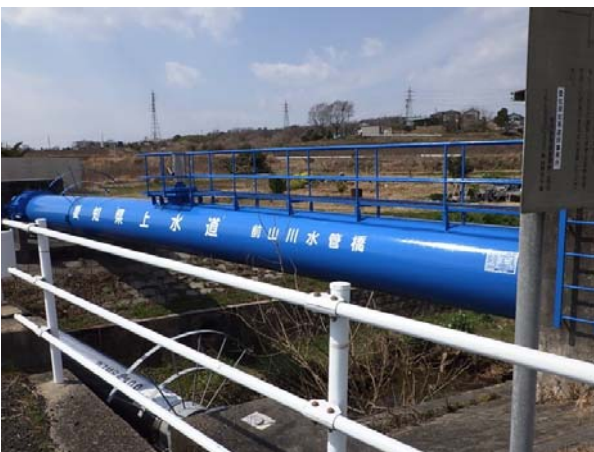
前山川水管橋
